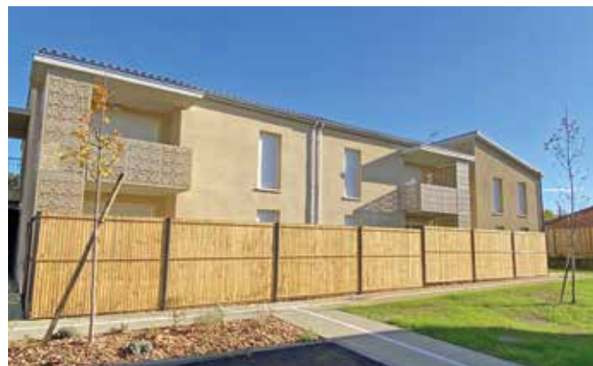
Bruguières - Résidence Le Feretra - 15 et 16 novembre 2022 3 logements collectifs locatifs
