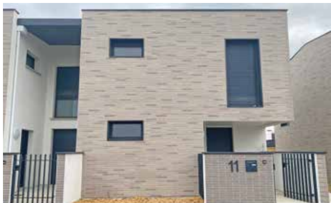
Beauzelle - Résidence Helios - 19 et 20 juillet 2022 29 logements individuels locatifs
